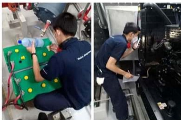
ภาพที่ 2-40 ตรวจสอบและบำรุงรักษา ระบบ Fire Pump และ Generator
