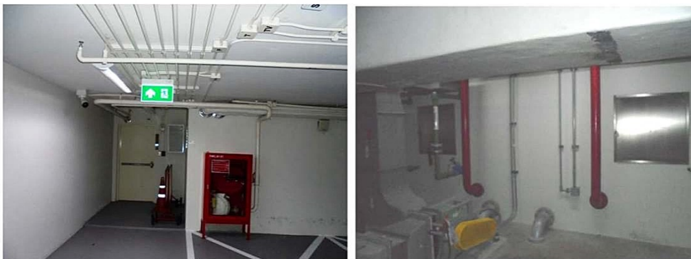
ภาพที่ 2-21 ตู้เก็บสายฉีดน้ำดับเพลิงพร้อมอุปกรณ์ และท่อเย็น
