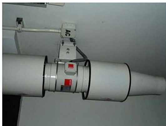
ภาพที่ 2-6 พัดลมระบายอากาศที่มีตัวกรองอากาศ
