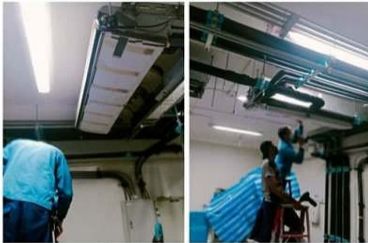
ภาพที่ 2-42 กำลังทำความสะอาดเครื่องปรับอากาศ
