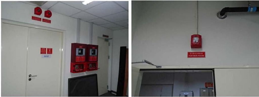
ภาพที่ 2-23 อุปกรณ์แจ้งเหตุโดยใช้มือดึง กริ่งสัญญาณเตือนภัย และโทรศัพท์ฉุกเฉิน
